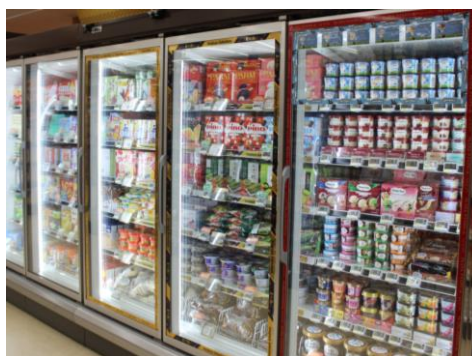
高効率冷蔵冷凍ショーケース導入
